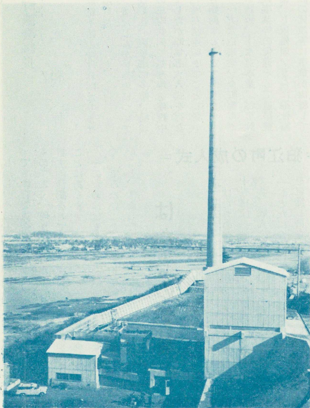
＜完成したじんかい焼却場＞
